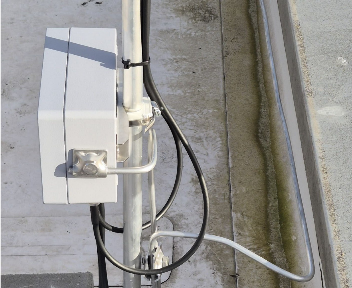
Bild zeigt die grundsätzliche Montage. Hier wurde der MIMO-Blitzschutz verwendet
